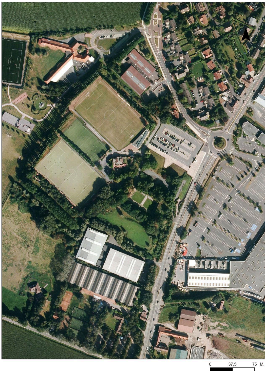
Vue aérienne en 2015 du fort, en grande partie remblayé (Source IGN. Photothèque nationale. 2015).
