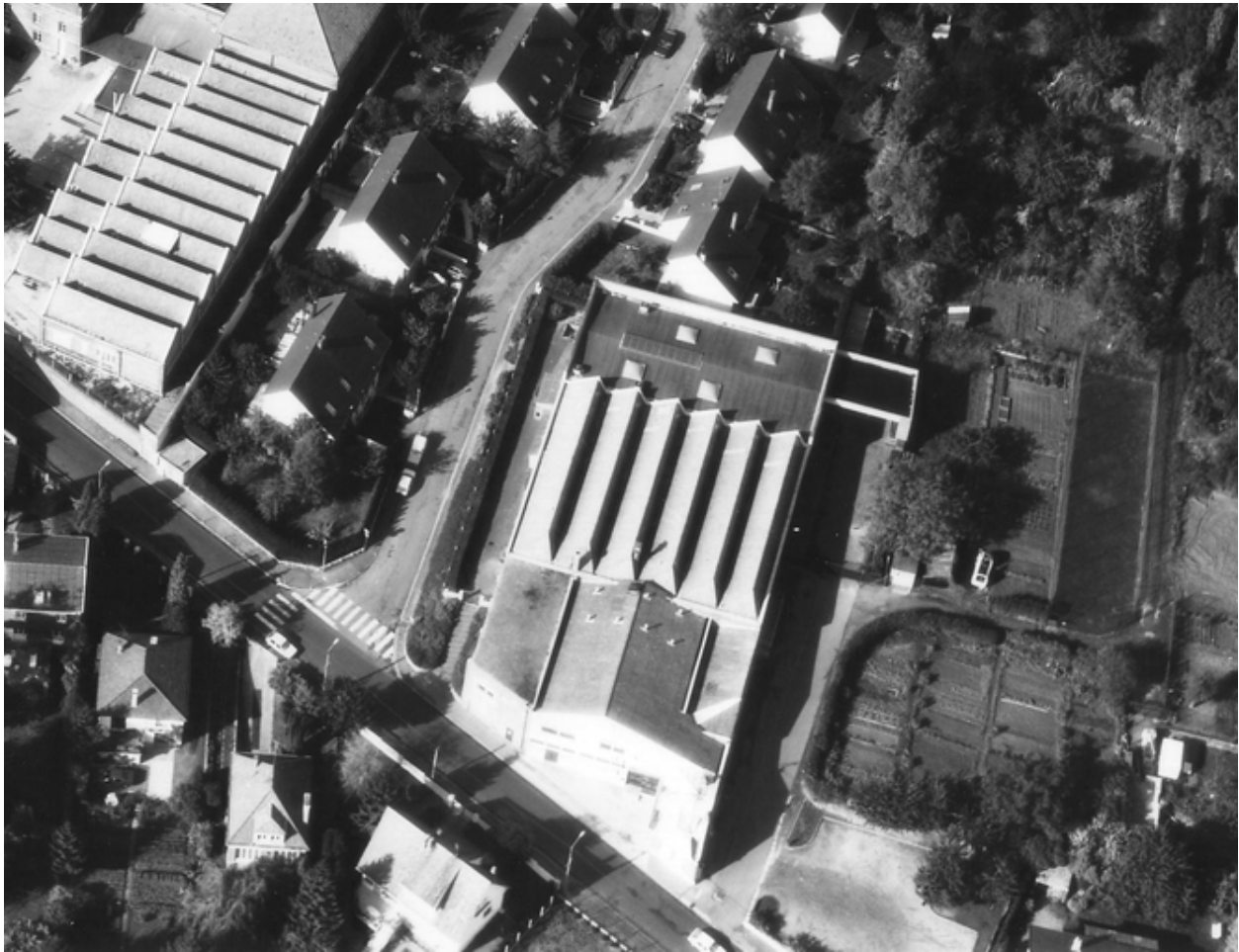
Vue aérienne de l'usine (en haut, à gauche, l'ancien tissage Sébastien) en 1989.
