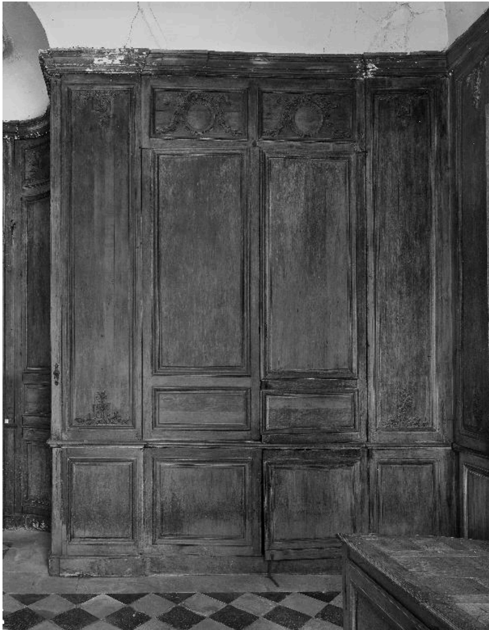
Vue des lambris du mur nord et des battants d'un placard encastré.
