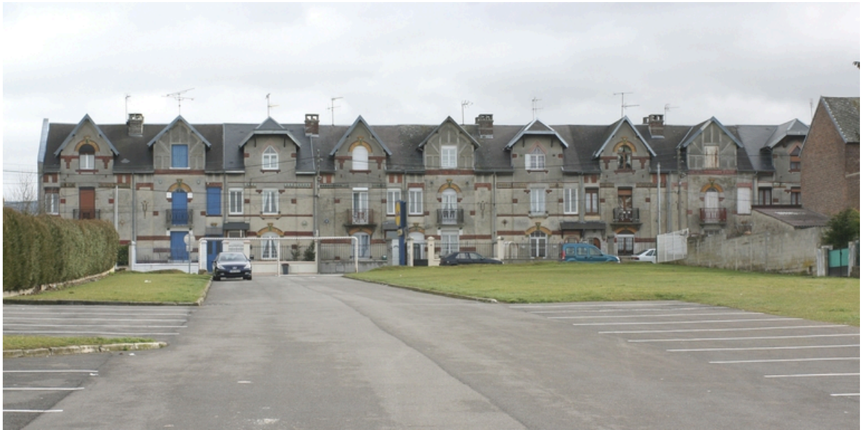
Façade antérieure des logements construits par M. Effroy, rue Jean-Richepin.
