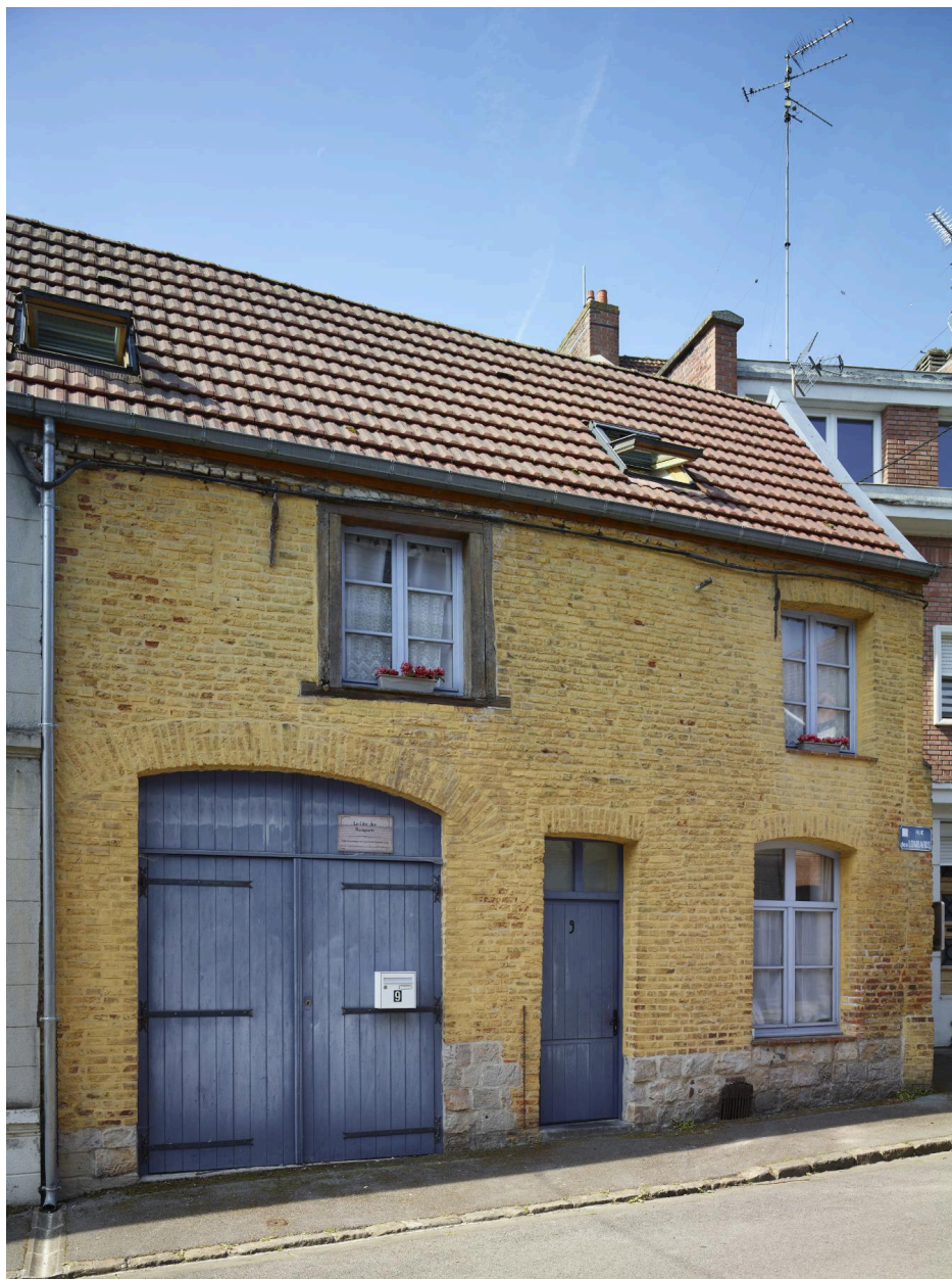
Maison limite XVIIIe-XIXe siècles recouverte d'un badigeon ocre jaune, et fer d'ancrage avec feuille nervurée sur le nœud - 9, rue des Lombards.
