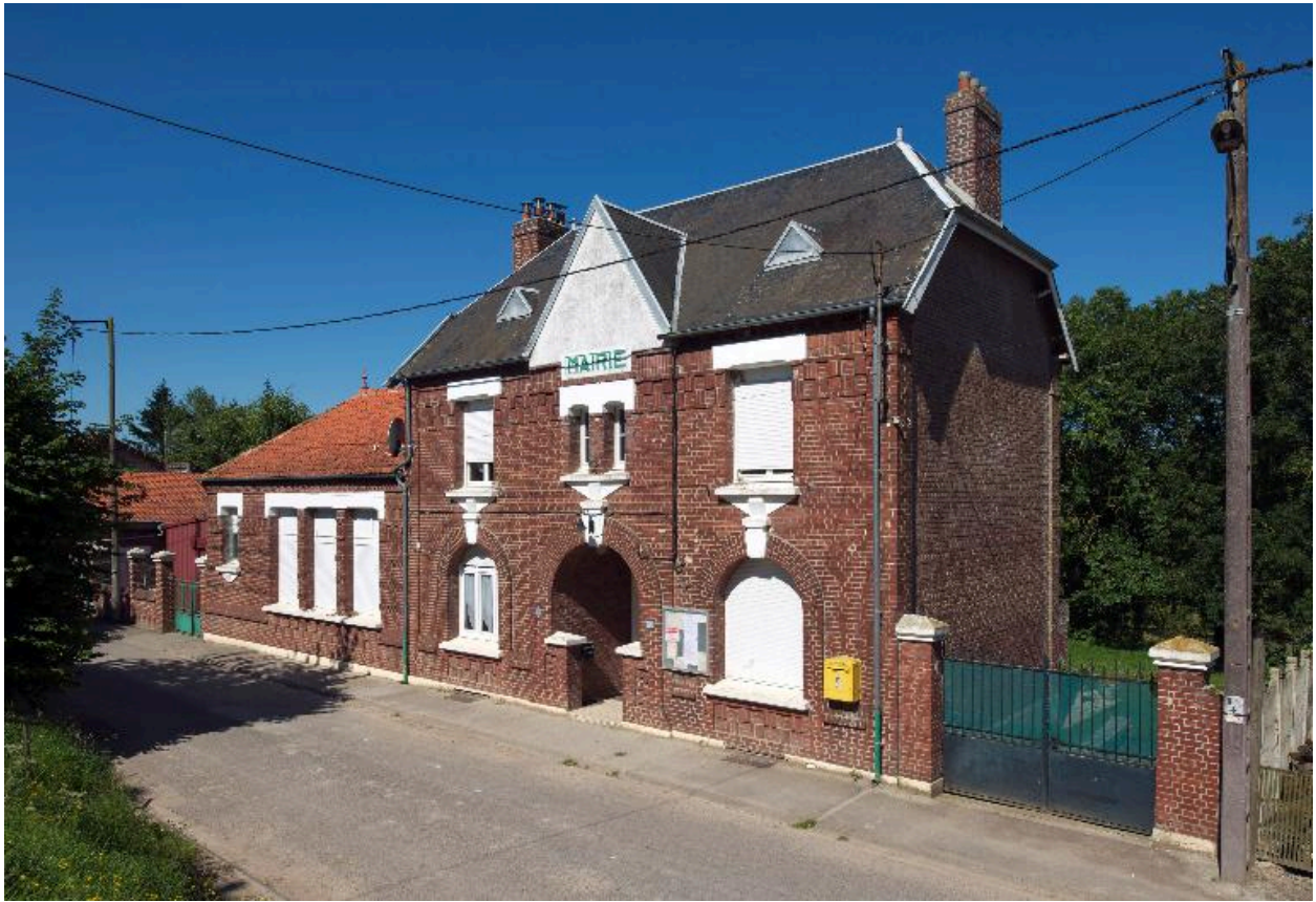
Vue de situation depuis le nord.
