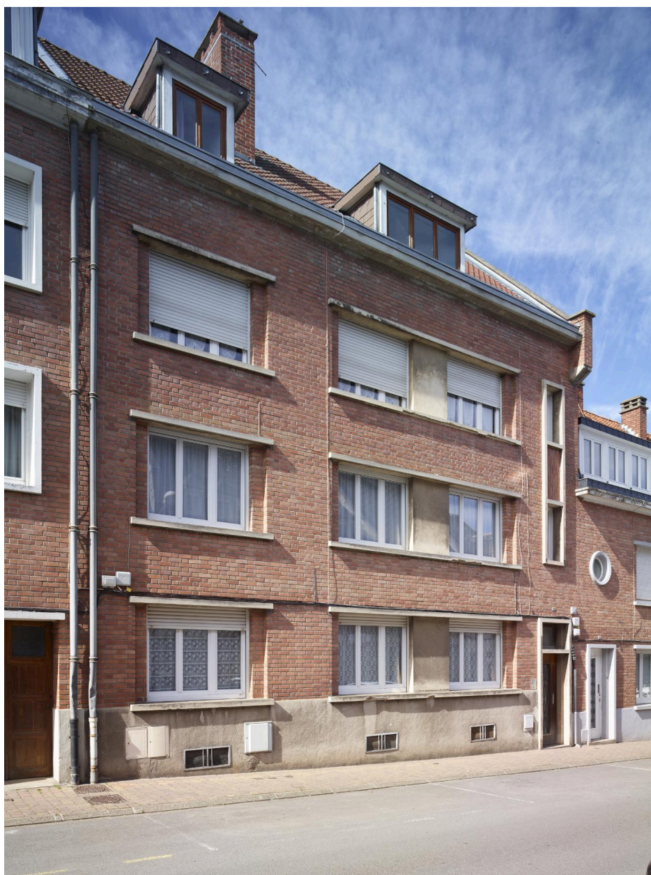
Détail de l'immeuble à logements, n°3.
