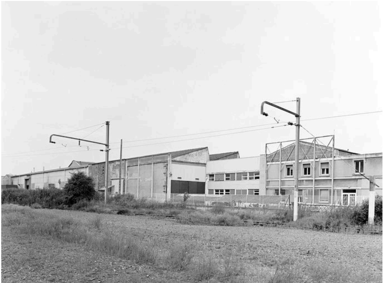
Vue générale de l'usine, flanc sud.
