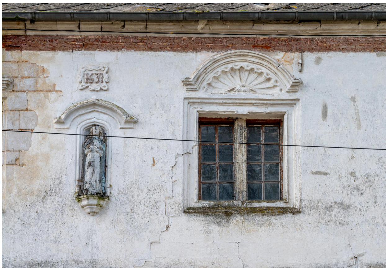
Façade antérieure de la maison (rue Principale). Détail du second niveau : niche couronnée d'une accolade, chronogramme dans son cartouche, fronton semi-circulaire en coquille d'une fenêtre.
