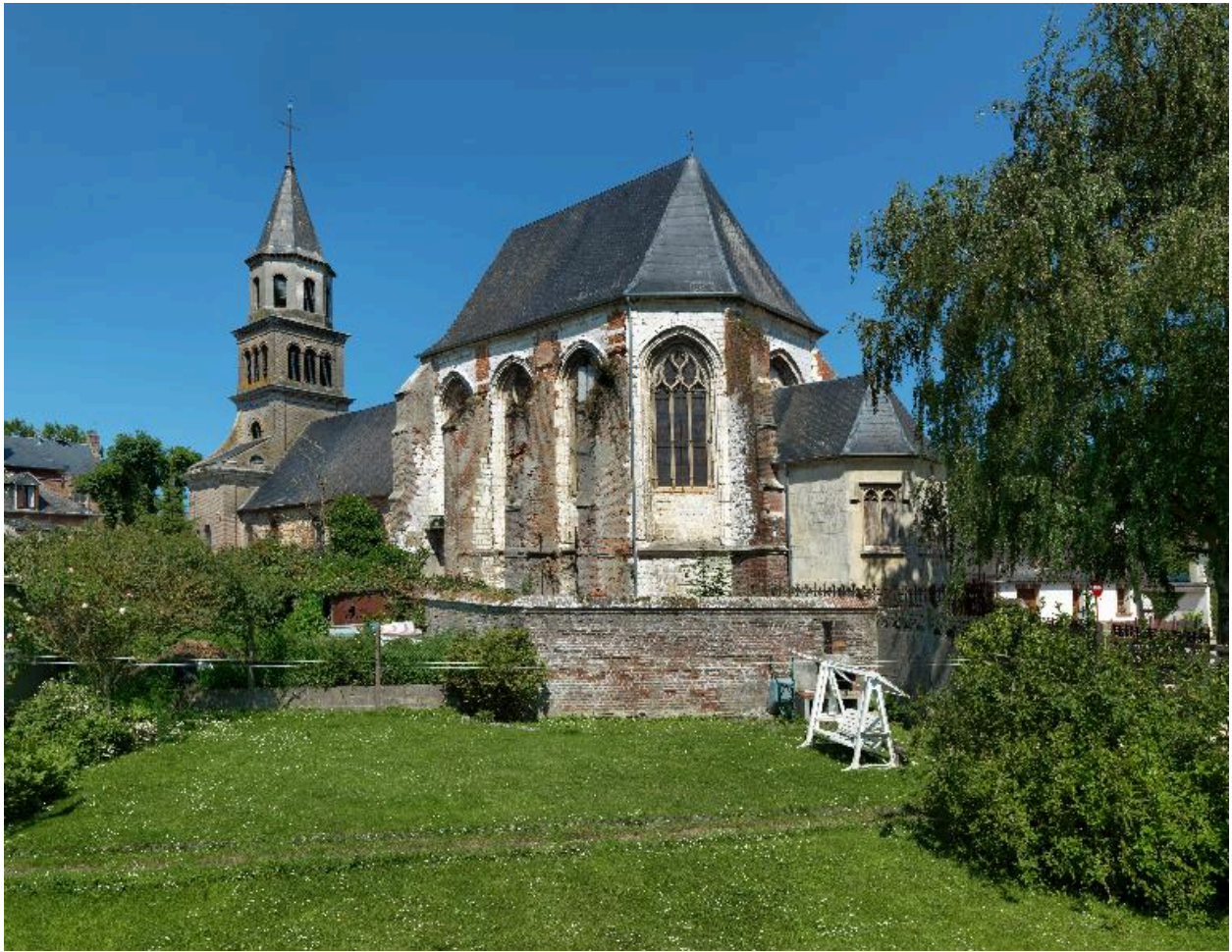
Vue de trois-quarts depuis la rue Émile-Zola.
