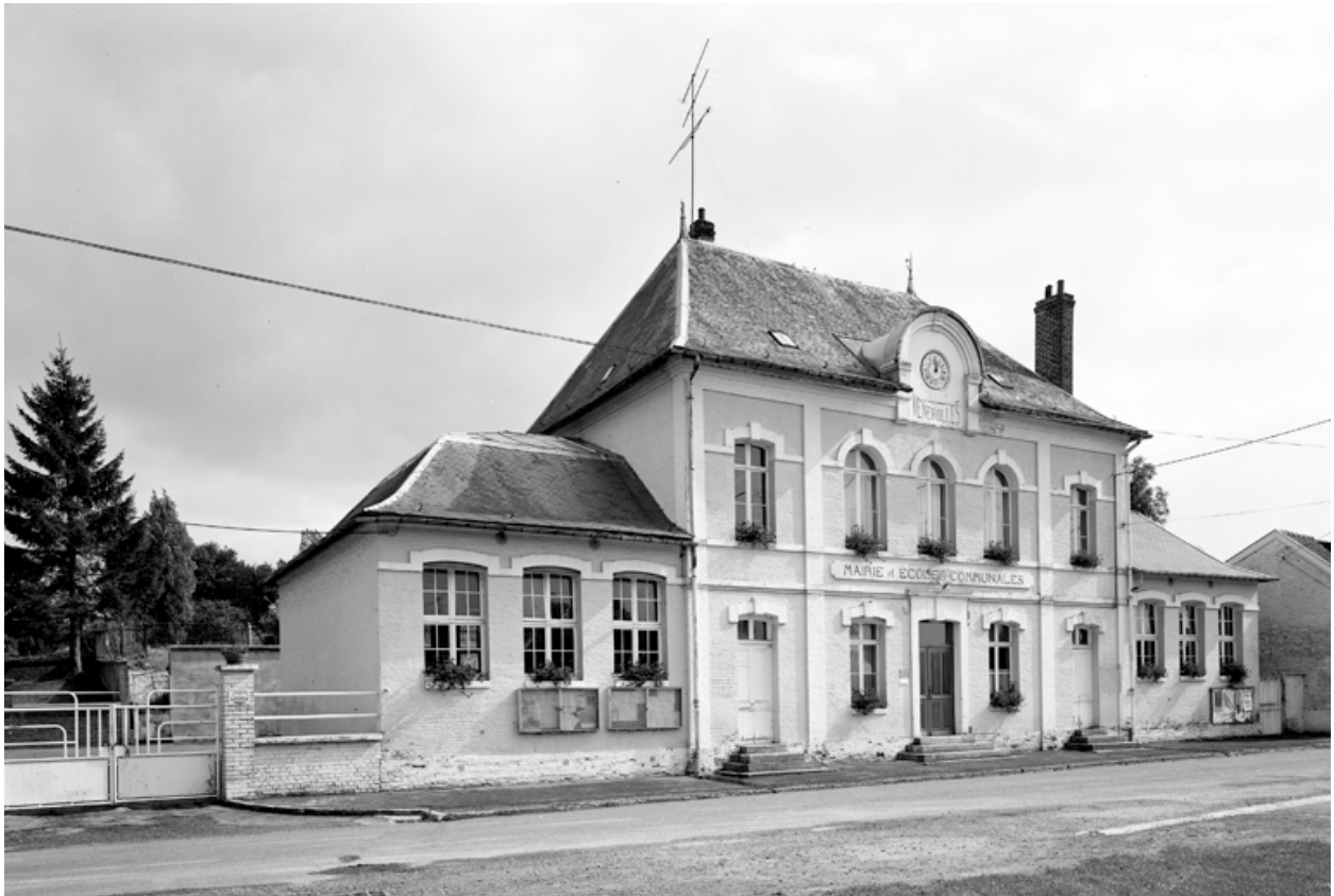
Vue d'ensemble de la façade.
