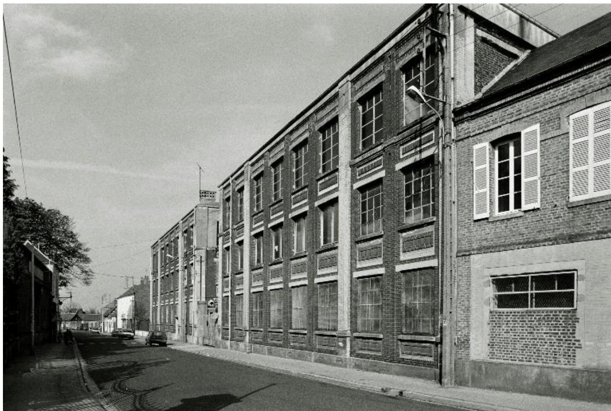
Façades de l'usine, rue Roger-Salengro, en 1988.
