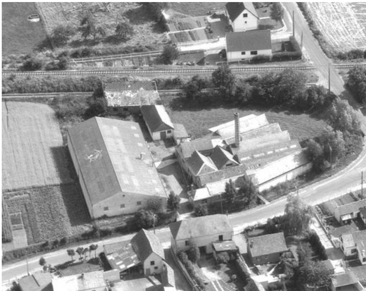
Vue aérienne, flanc nord.
