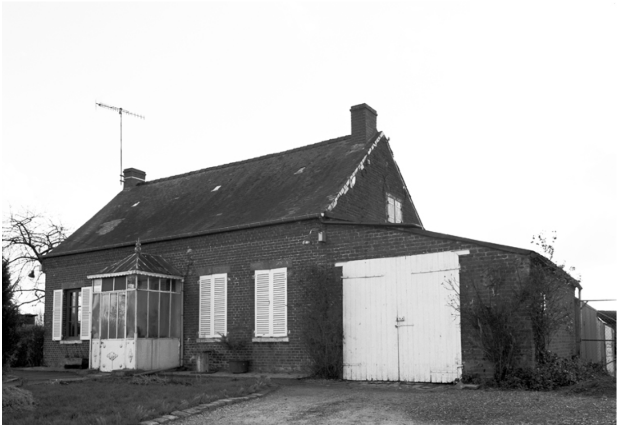
Esquéhéries, maison (étudiée), la Rue-des-Pires, 2 rue des Pires.
