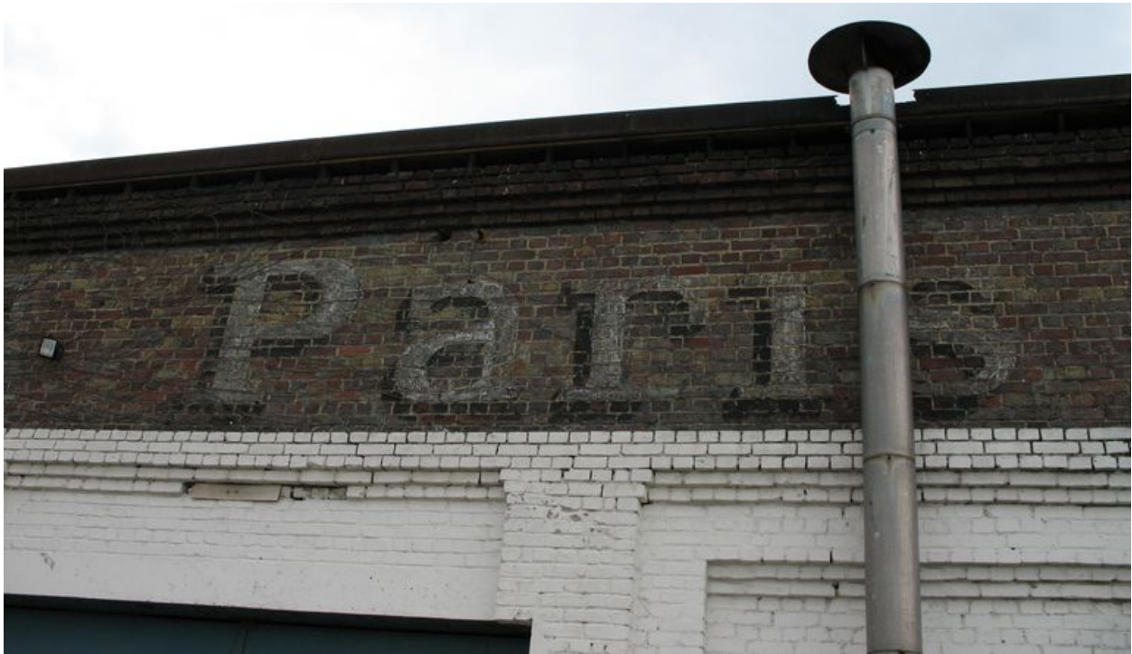
Détail des inscriptions sur le mur est.
