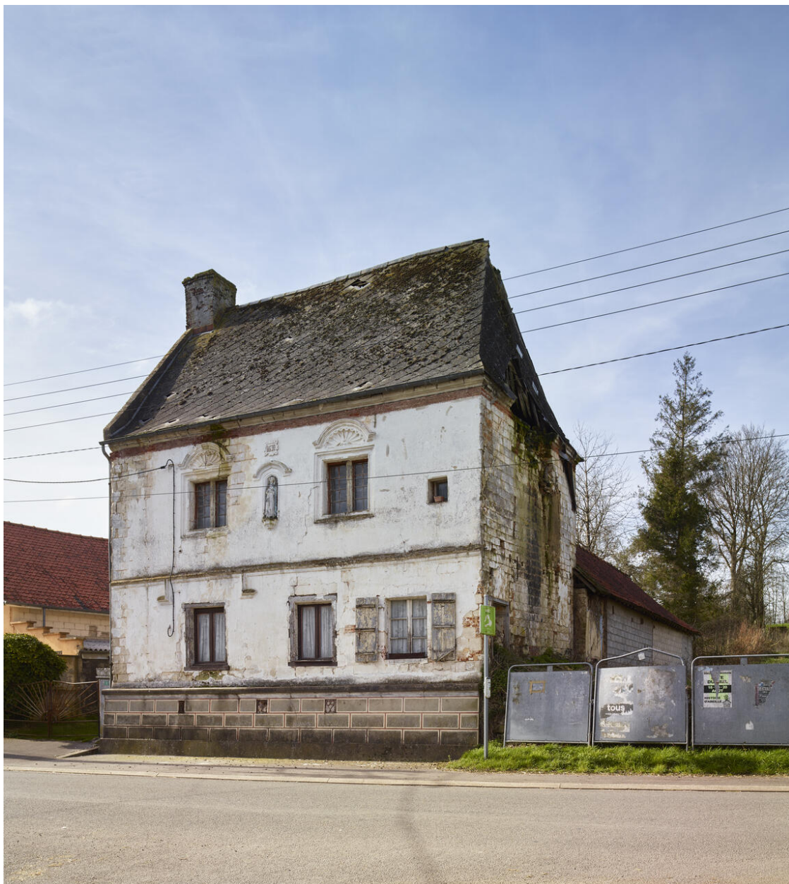
Vue générale, de trois quarts droit, de la façade antérieure de la maison (rue Principale).
