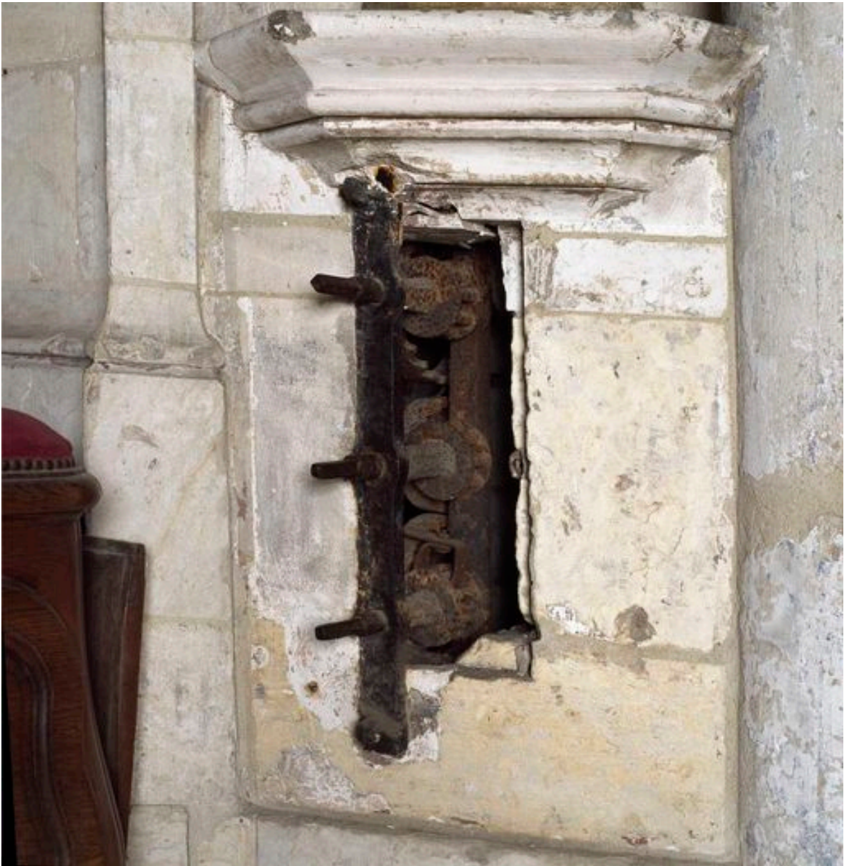
Détail du système d'ouverture des portes.
