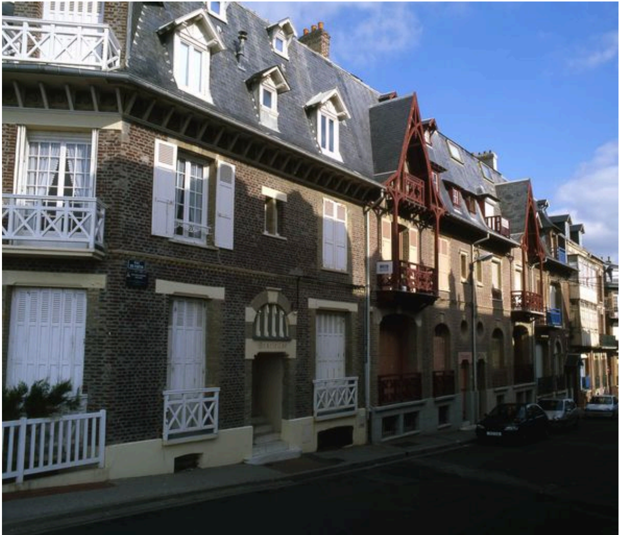
Vue des logements sur la rue Julien-Hédin, depuis l'esplanade.
