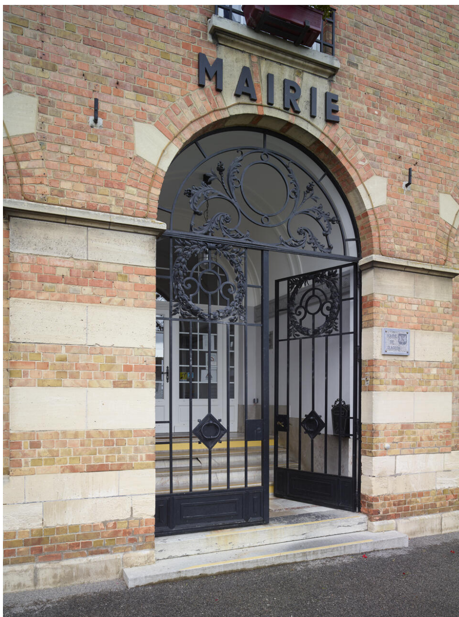
Détail de l'entrée.
