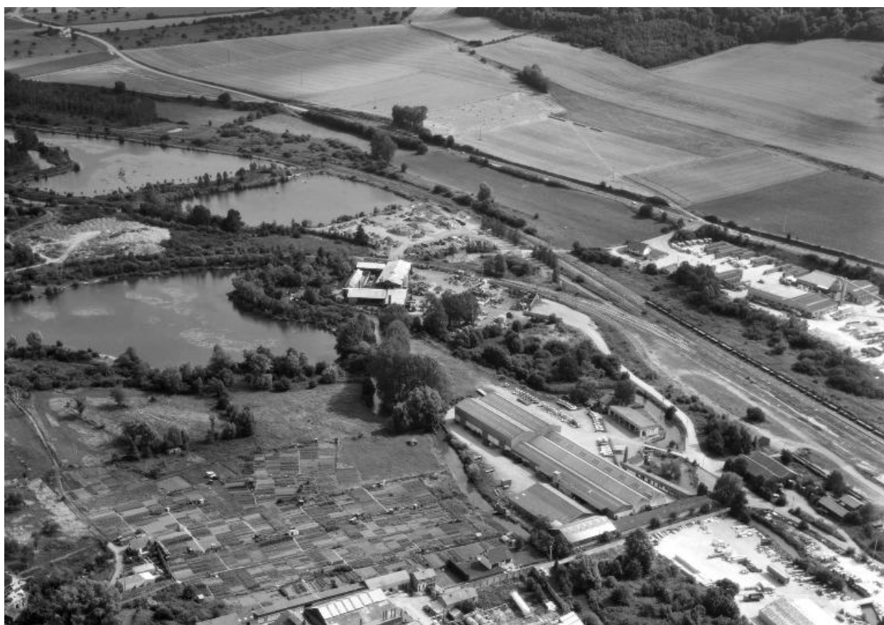
Vue aérienne, flanc ouest.
