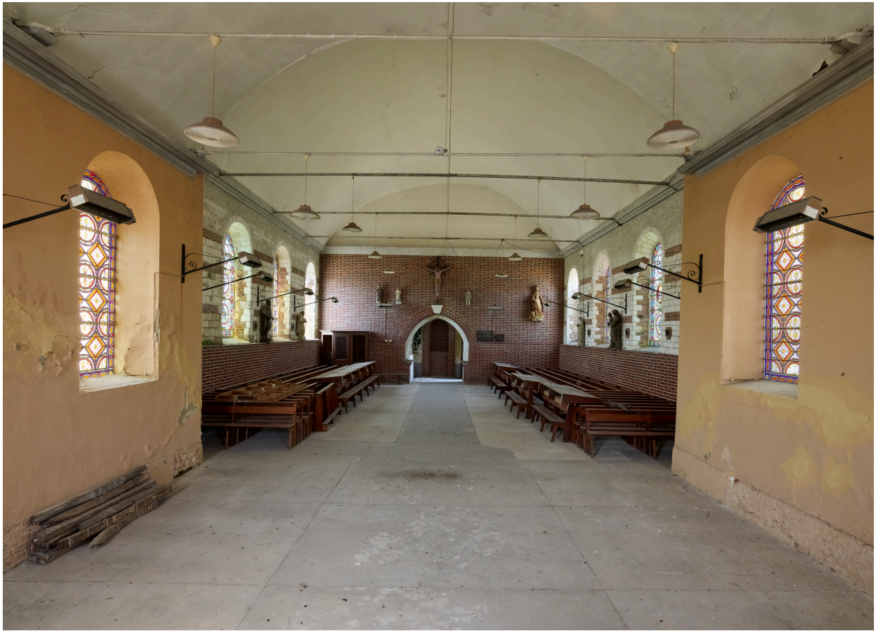
Intérieur, vue de la nef depuis le chœur.
