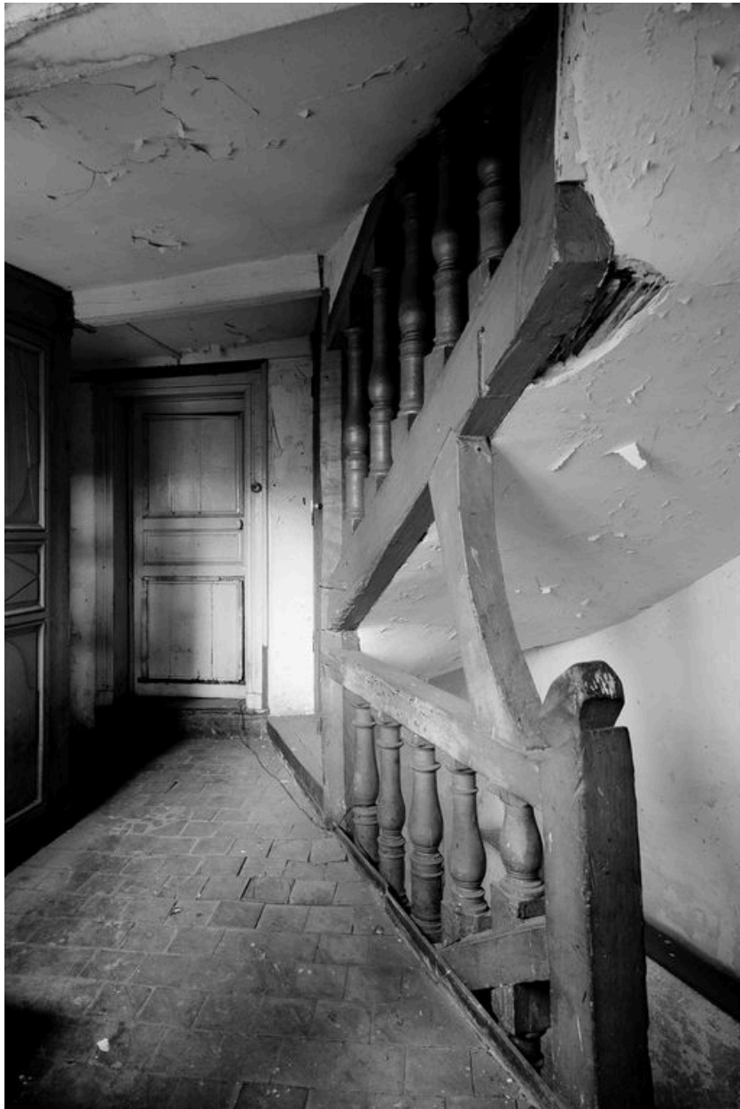
Vue intérieure : détail de l'escalier.
