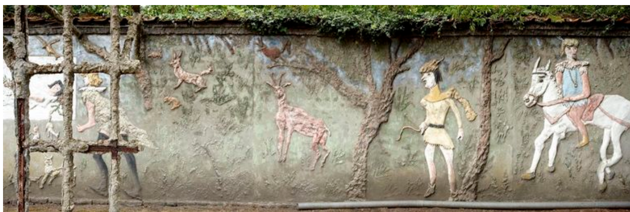
Palissade du jardin, vue générale.
