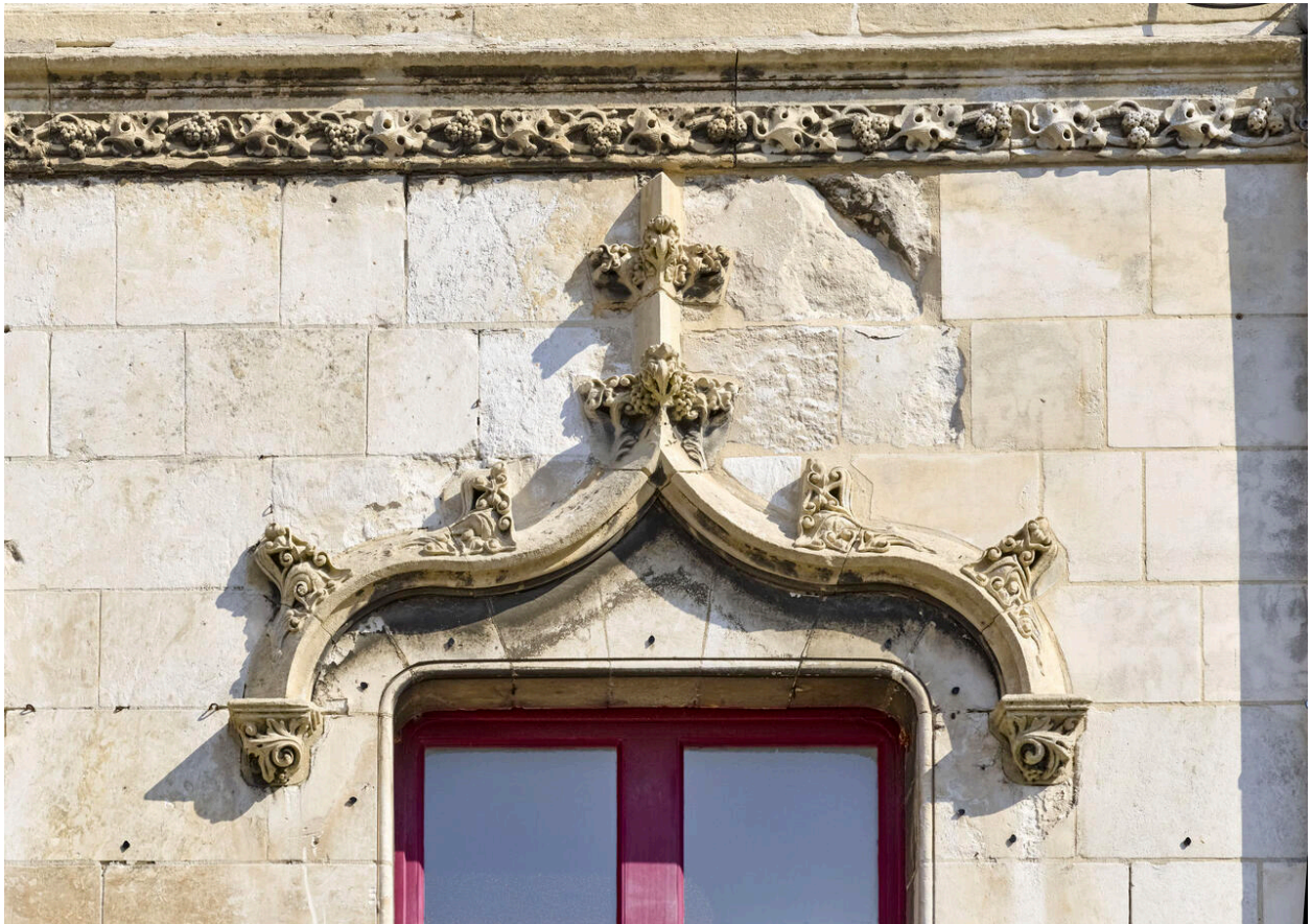
Détail du décor de la frise et d'un arc en accolade néo-gothique d'une des baies de la façade ouest.
