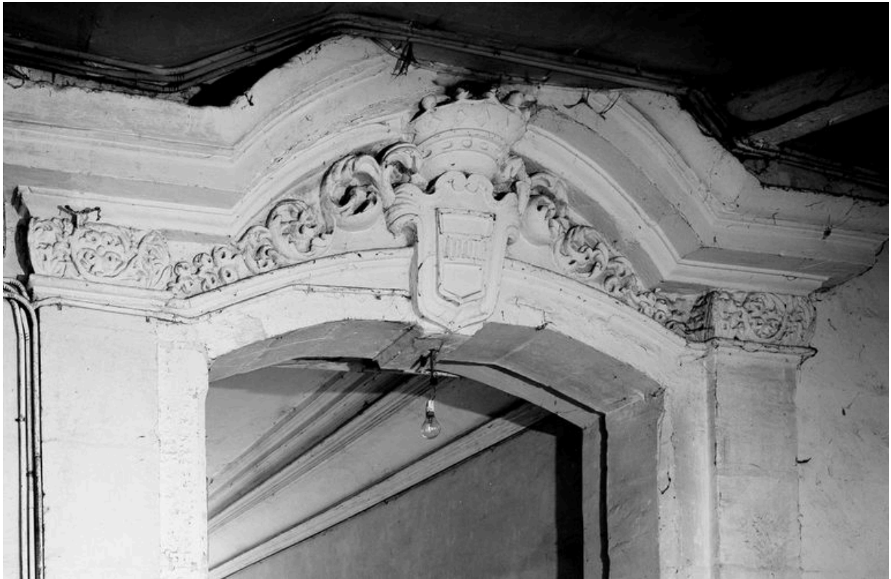
Élévation postérieure : détail du couronnement de l'arc ouvrant sur le couloir.
