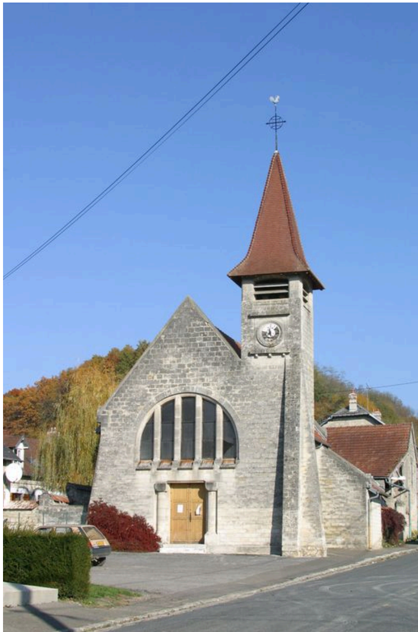
Vue générale de la façade ouest.
