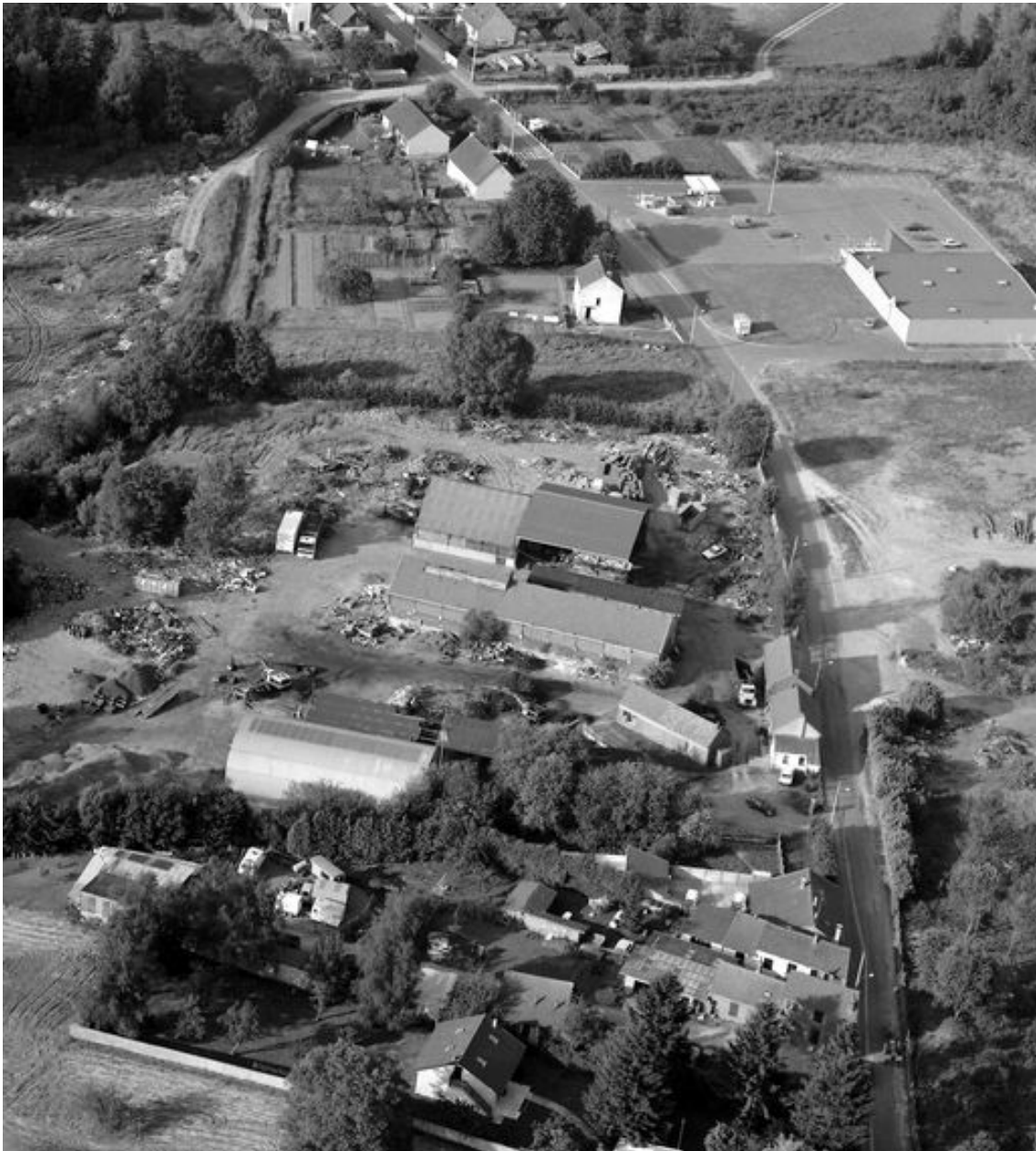
Vue aérienne du site industriel en 1994.
