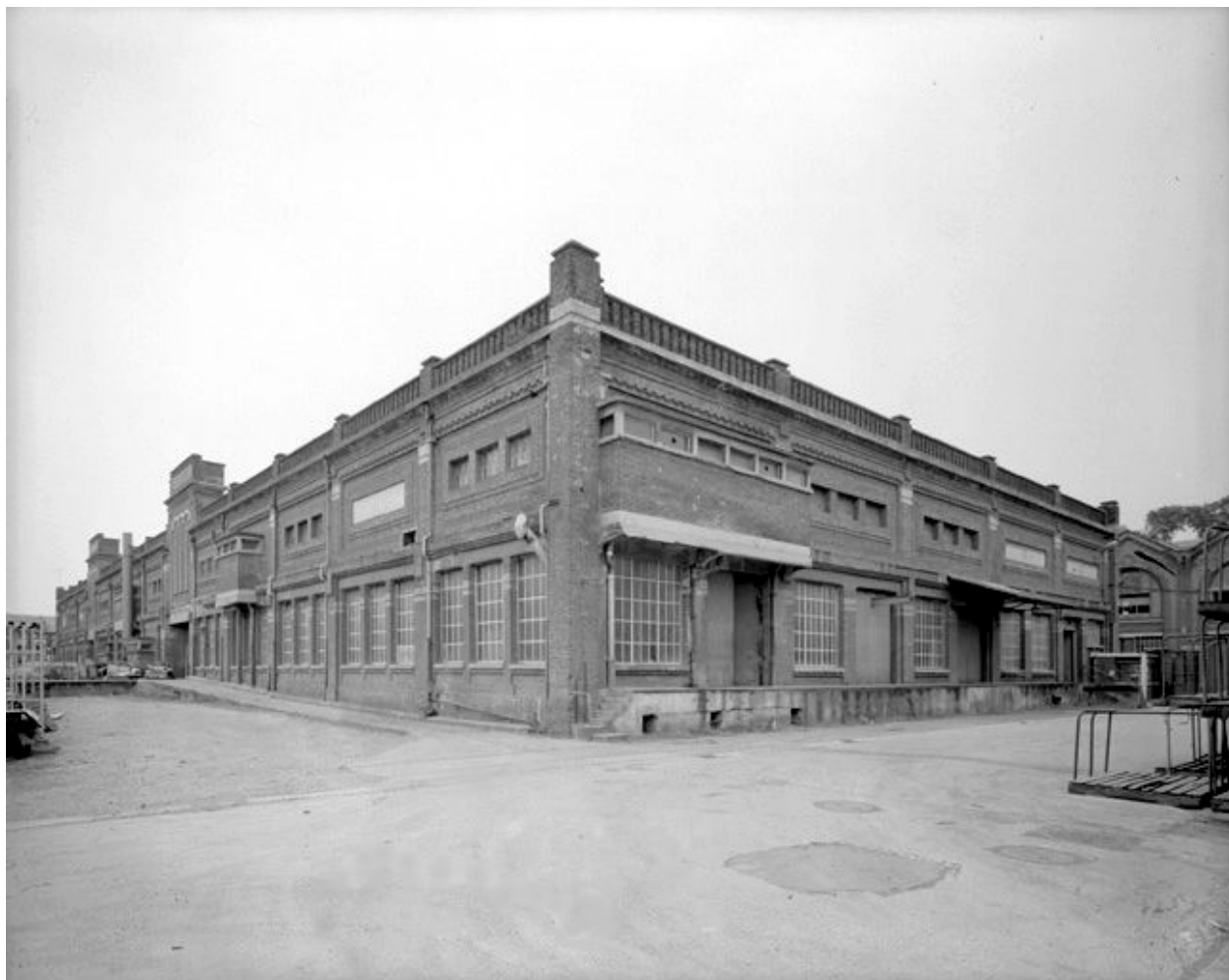
Les anciens magasins en 1988, avant transformation.
