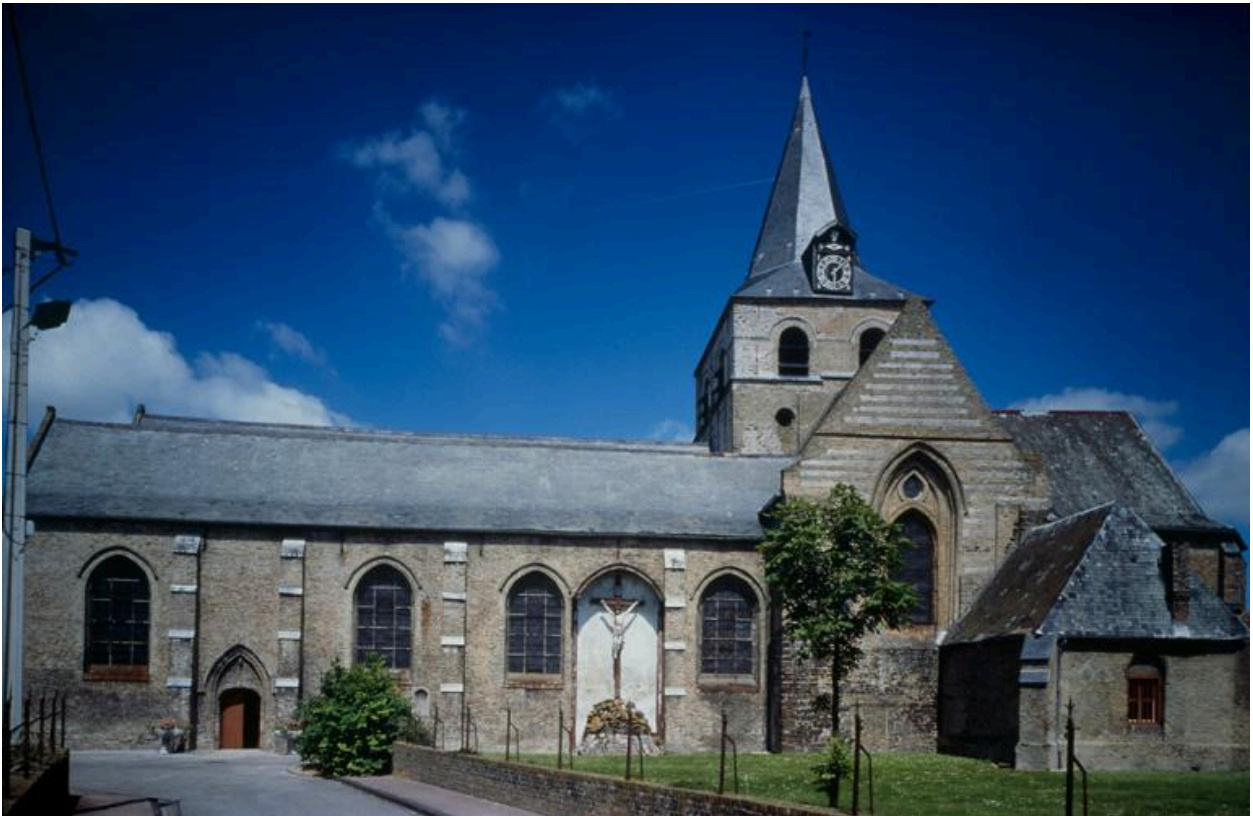
Vue générale de la façade sud.
