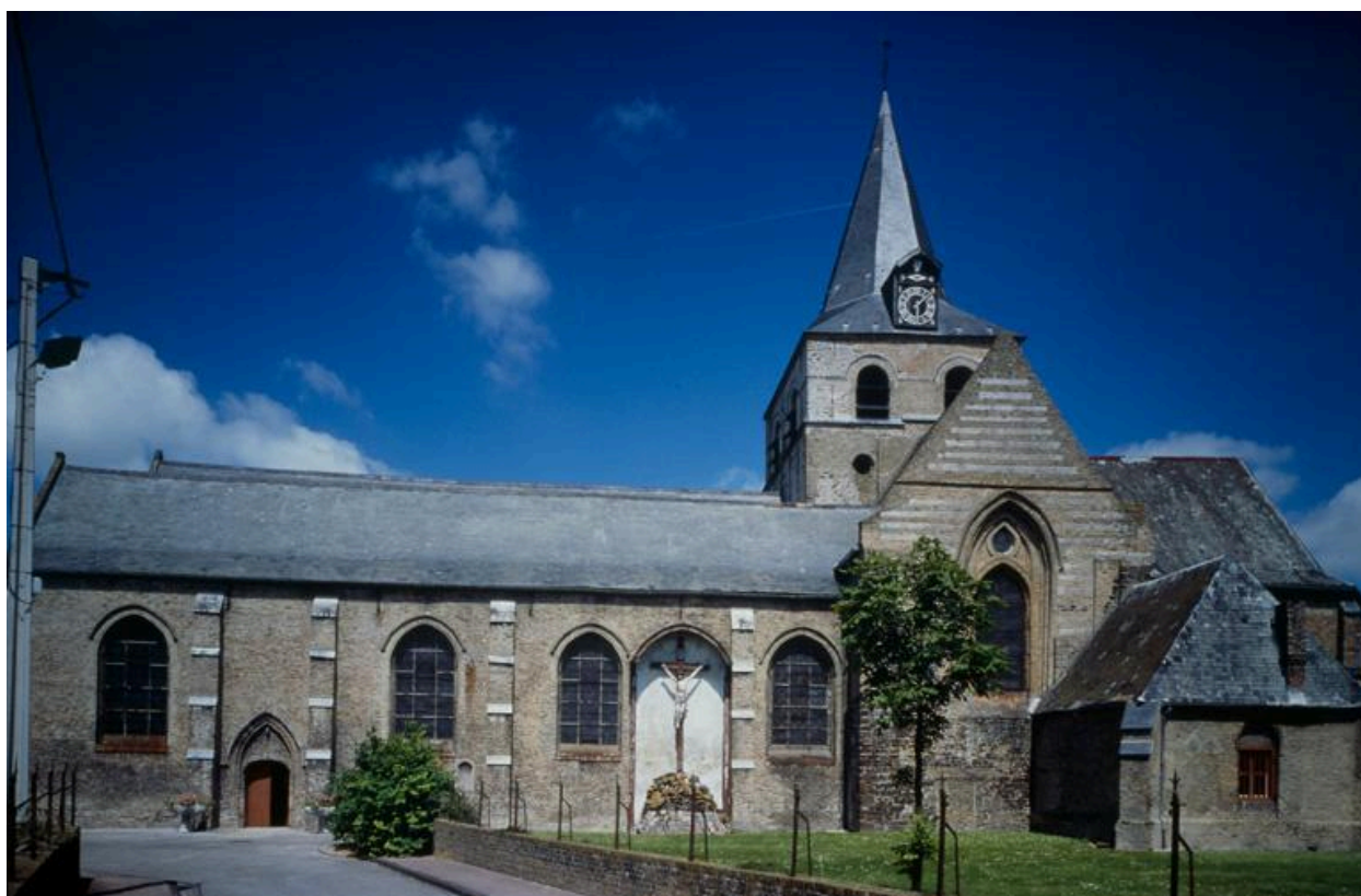
Vue générale de la façade sud.
