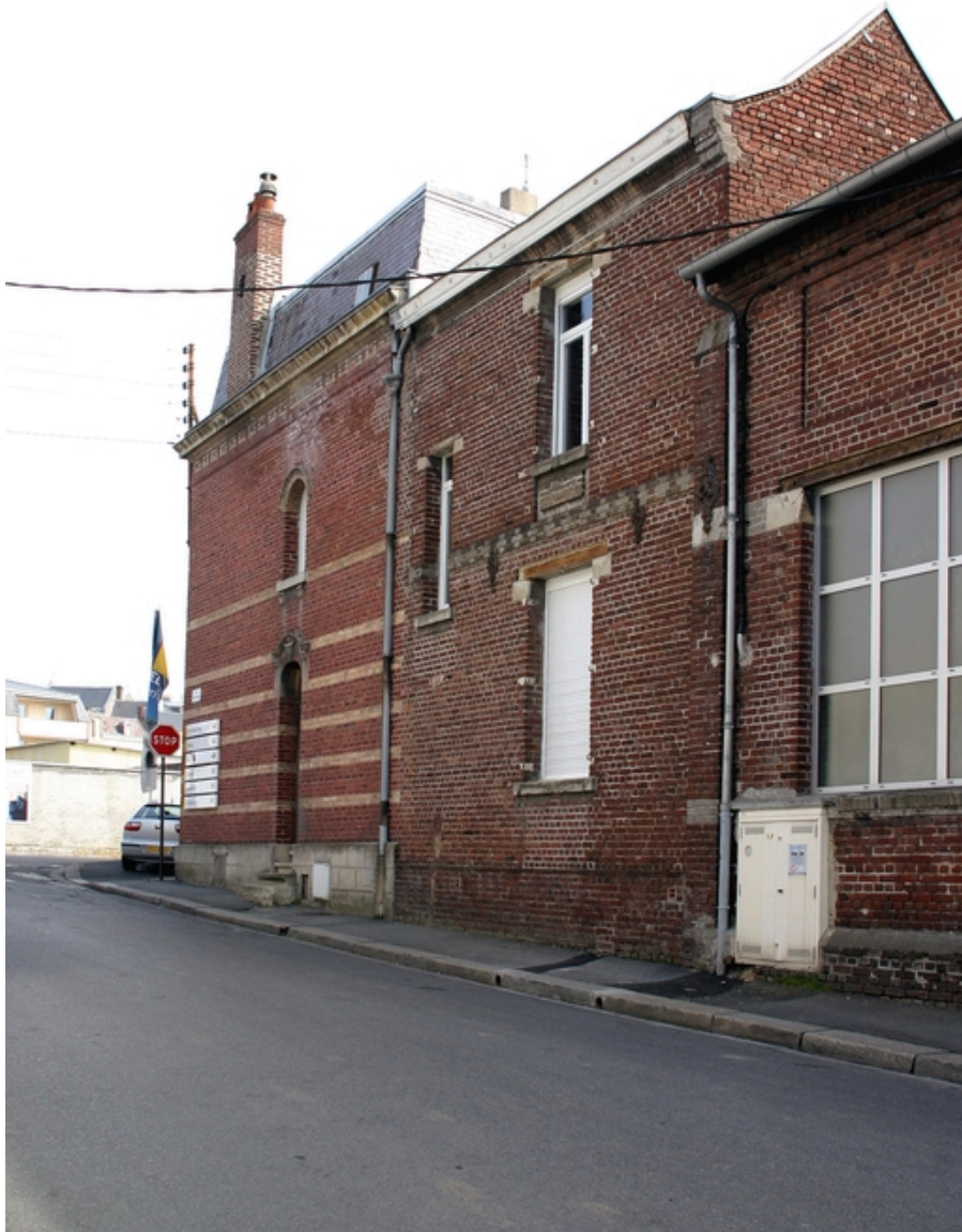
Logement patronal et bureaux, rue des Islots.
