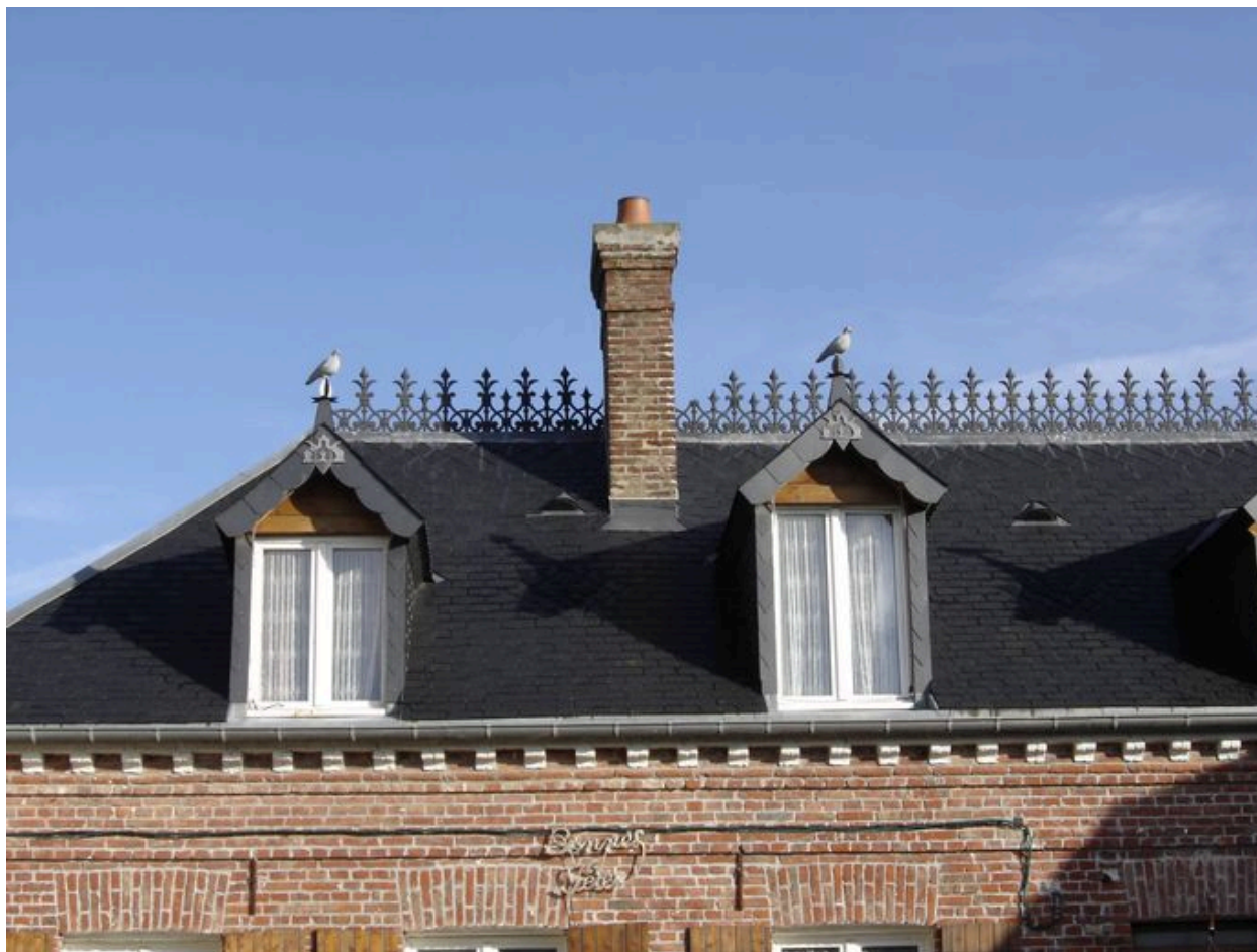
Vue détaillée de la crête en zinc.
