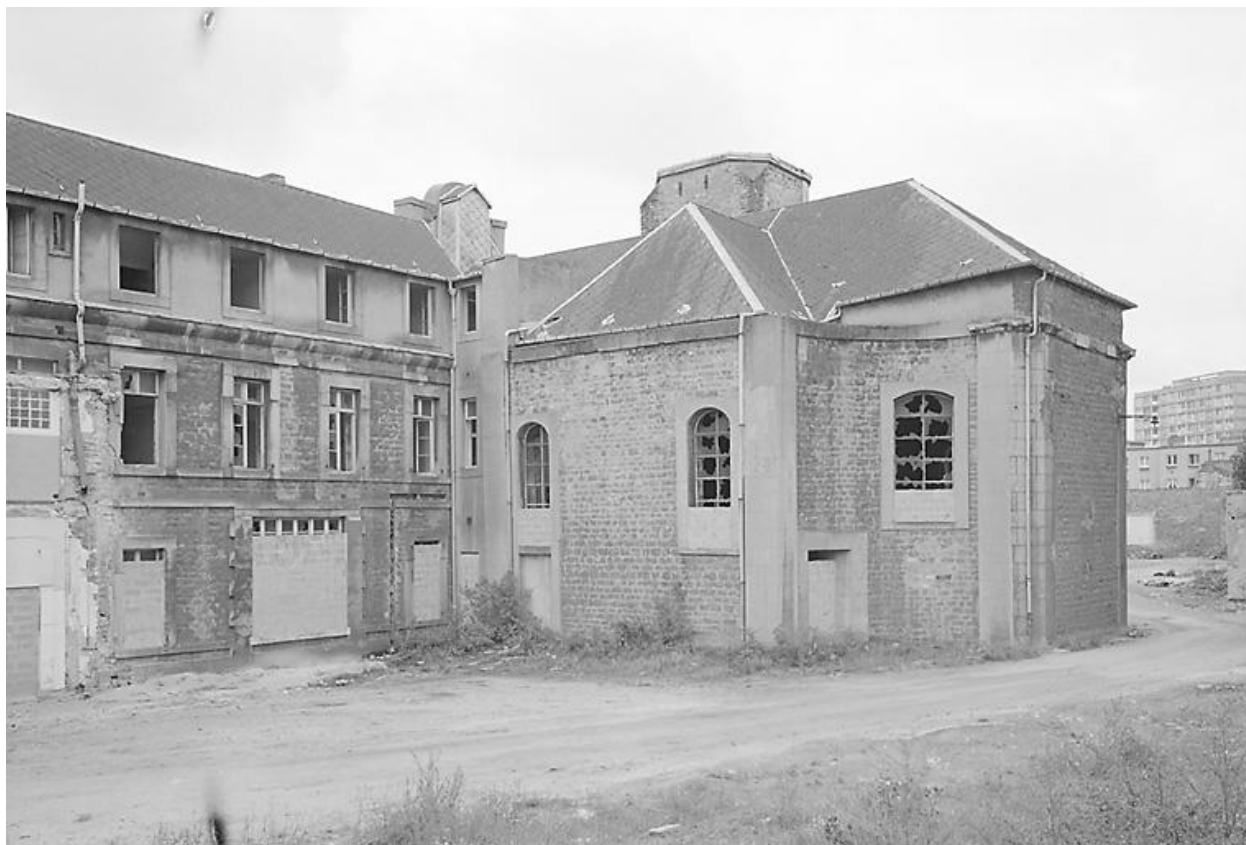
Bâtiment C, chapelle, vue d'ensemble nord rue du Vivier.
