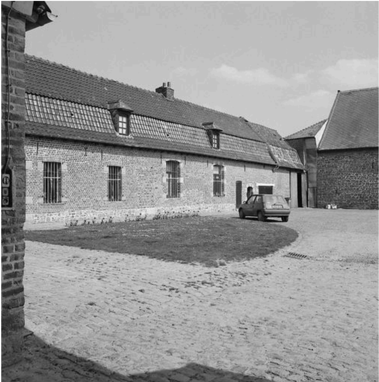
Vue générale du logis, élévation antérieure.
