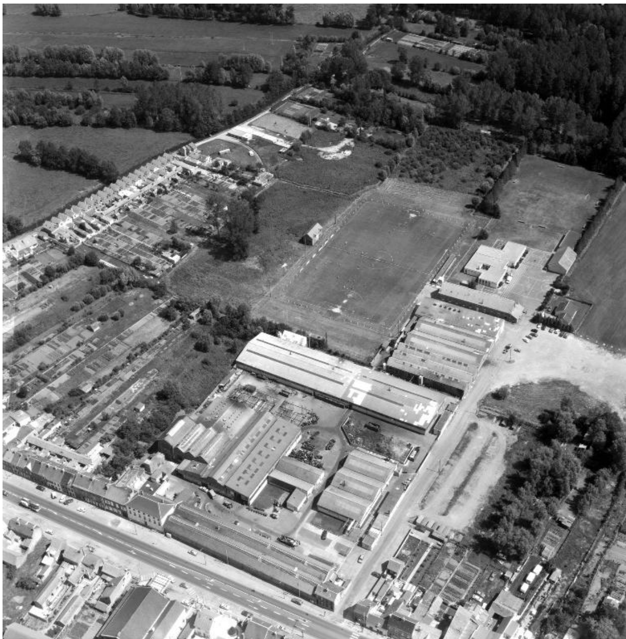
Vue aérienne de 1990, flanc nord-ouest.
