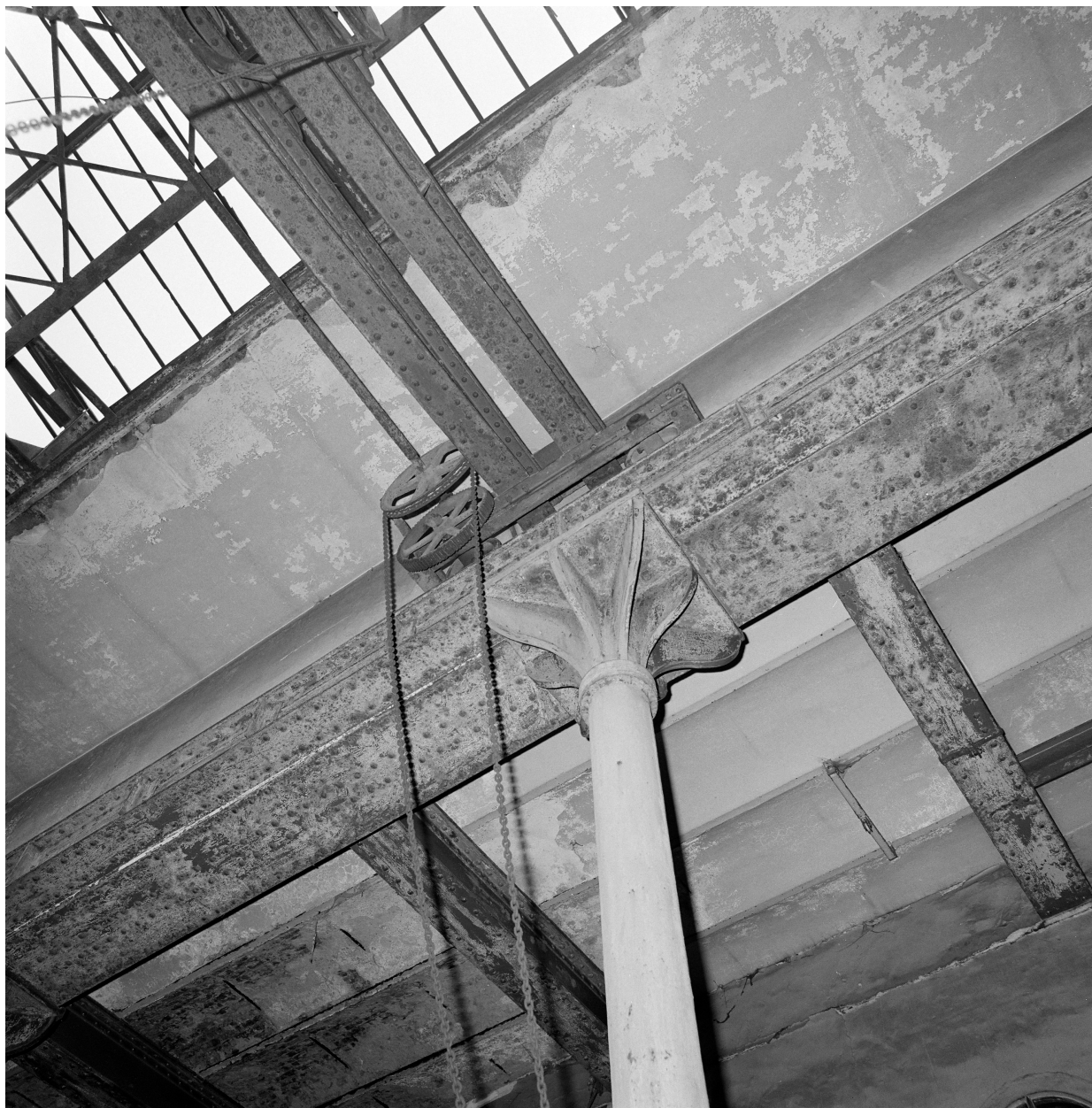
Salle des machines. Chapiteau de colonne et mécanisme du pont roulant.
