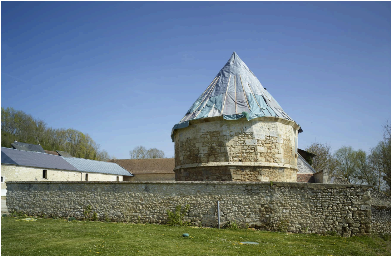
Vue générale du colombier depuis le jardin en terrasse.
