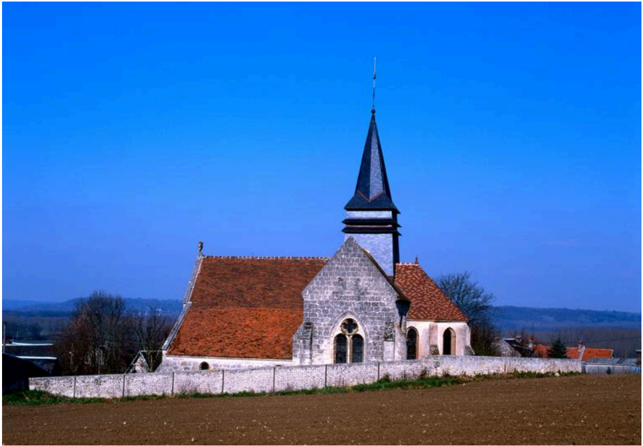
Vue de l'élévation sud.
