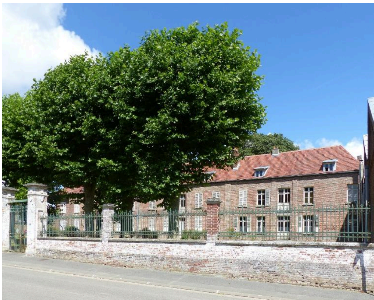
Ancienne fabrique, puis logement patronal.
