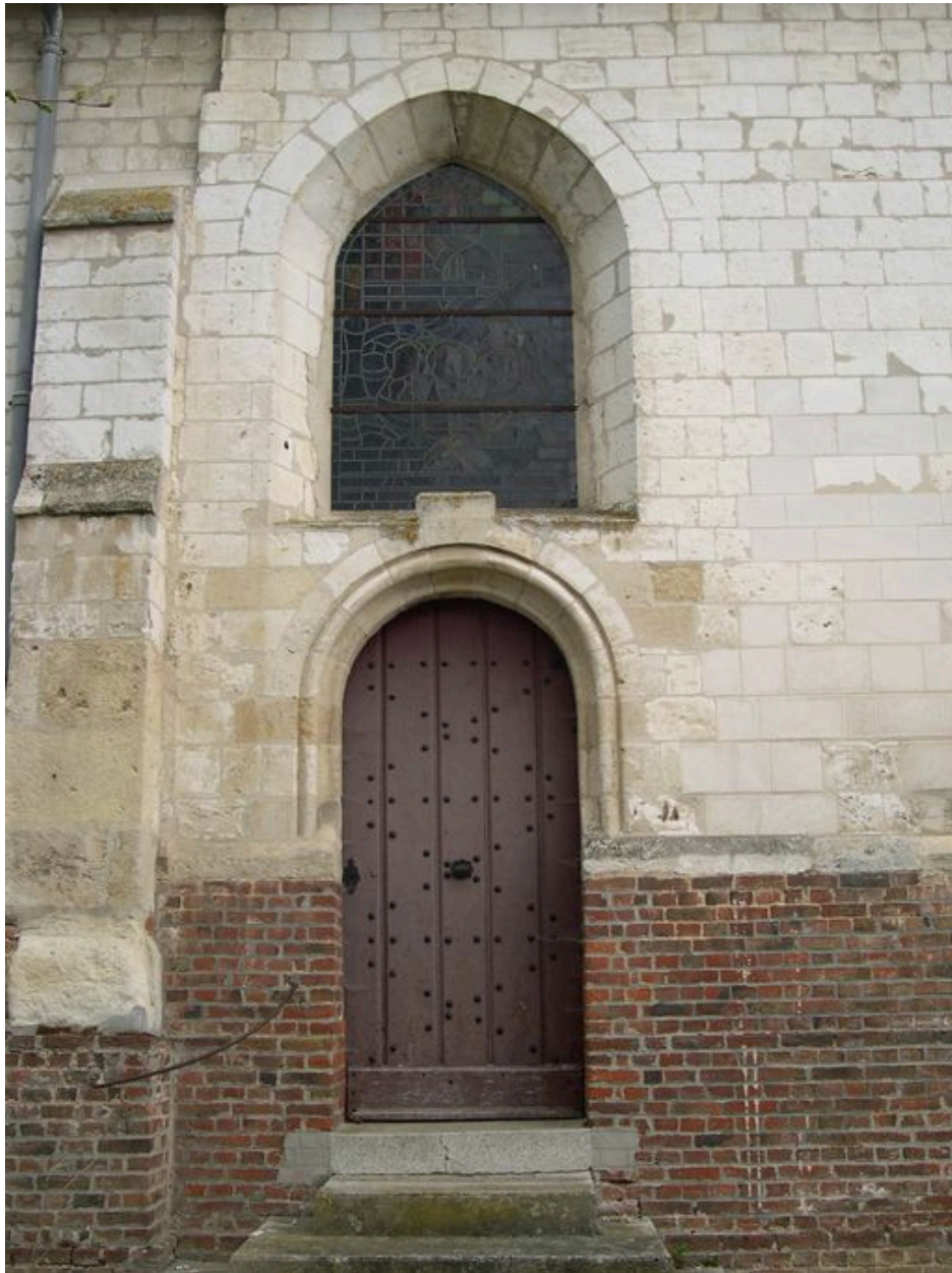
Porte sud de la nef.
