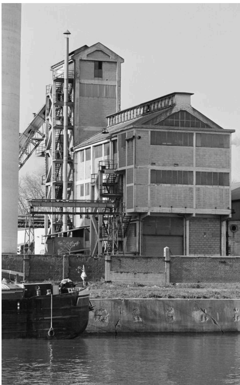
Atelier de fabrication : flanc est.
