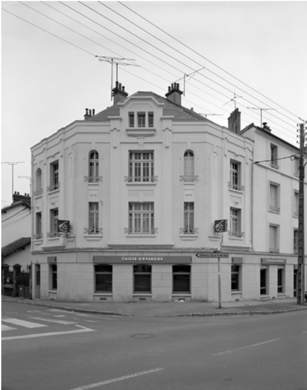
Vue d'ensemble du bâtiment, 1938, architecte G. Vaudeschal.
