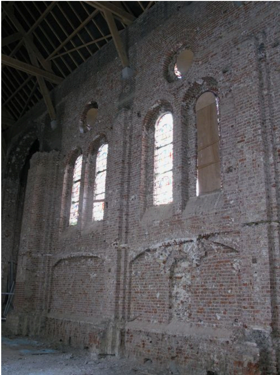
Mur sud de la nef
