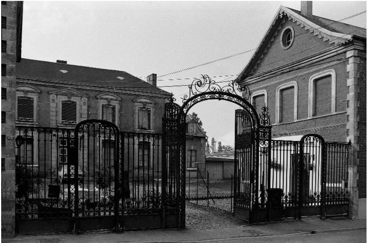
La grille du logement patronal, en 1990.
