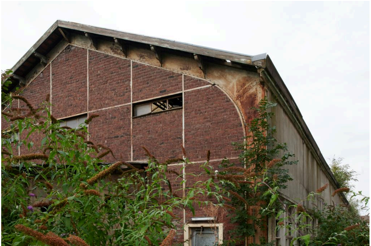
Détail du pignon sud-est en pans de fer et de la ferme métallique du magasin sud.
