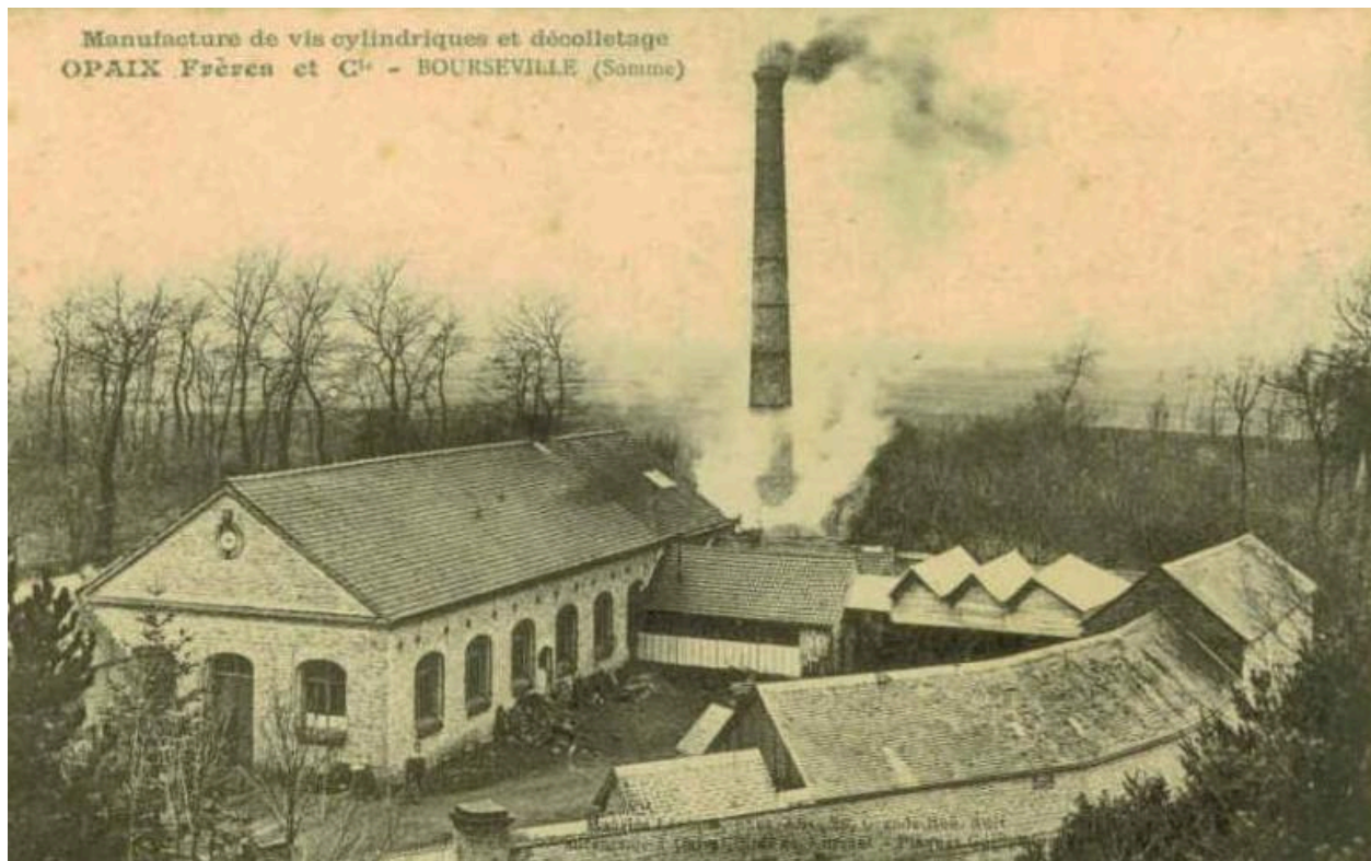
Bourseville. Vue générale de l'ancienne usine Opaix Frères et Cie. Carte Postale, vers 1905 (coll. part.).
