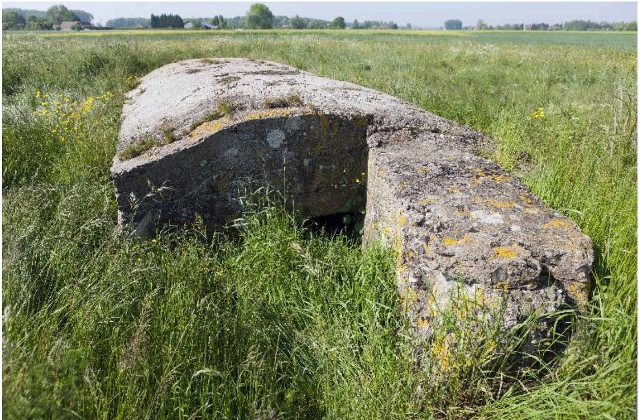
Casemate nord, entrée nord
