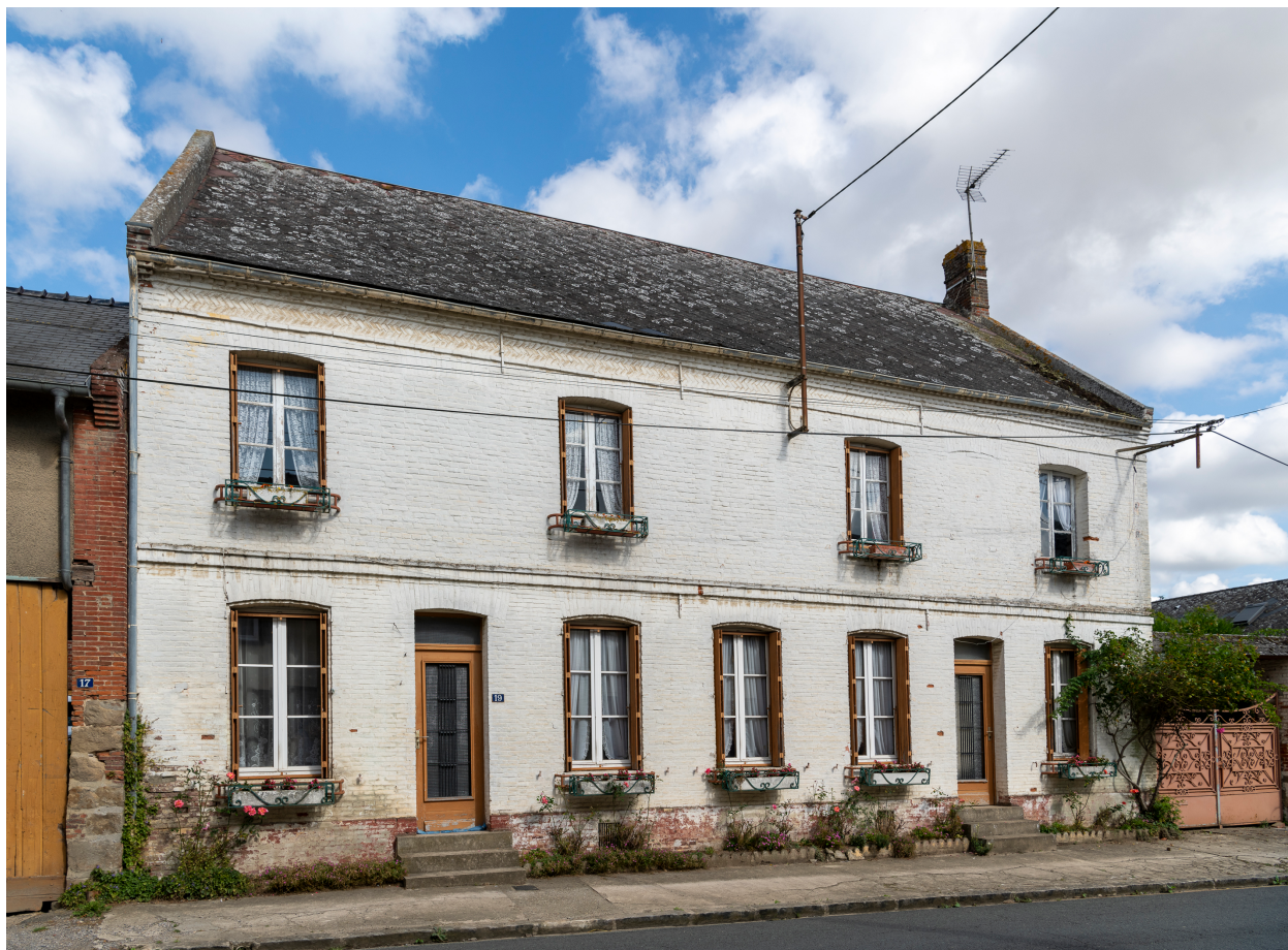
Anciens logements d'ouvriers (?), n°19 de la rue du Bail, vue depuis le sud.
