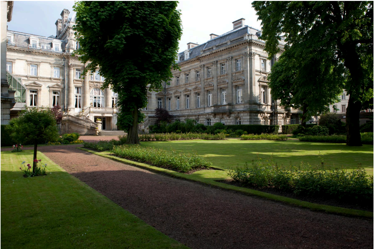
Vue de la façade depuis les jardins.
