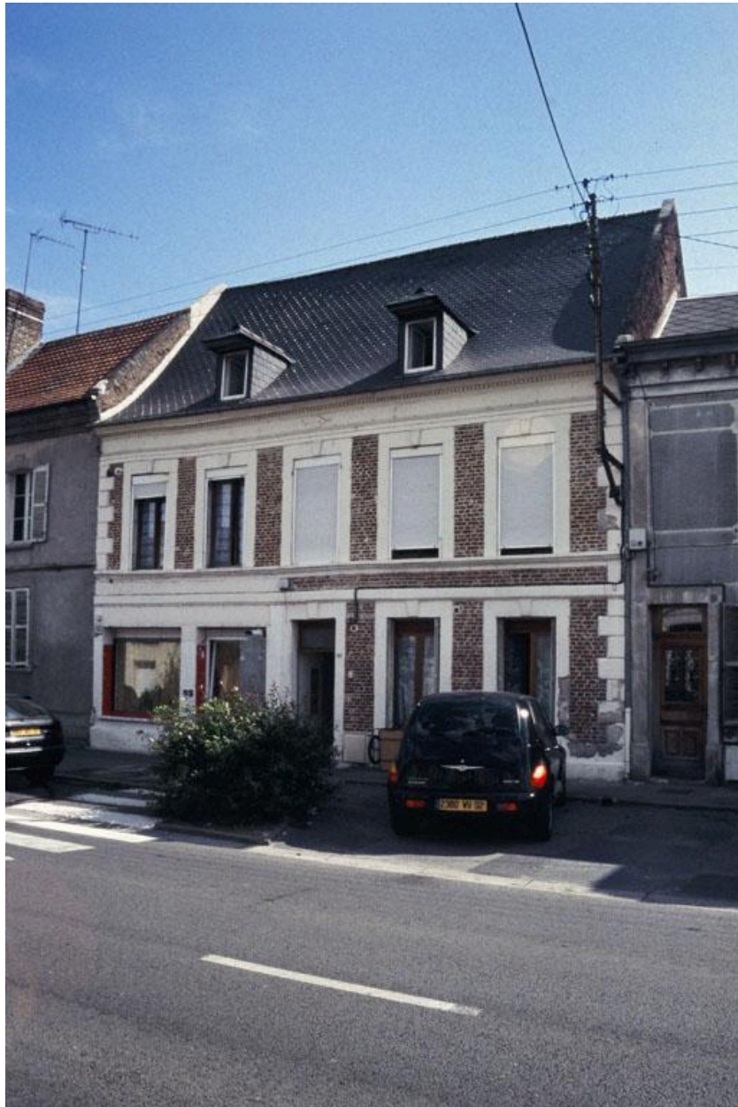
Vue de la façade sur rue.
