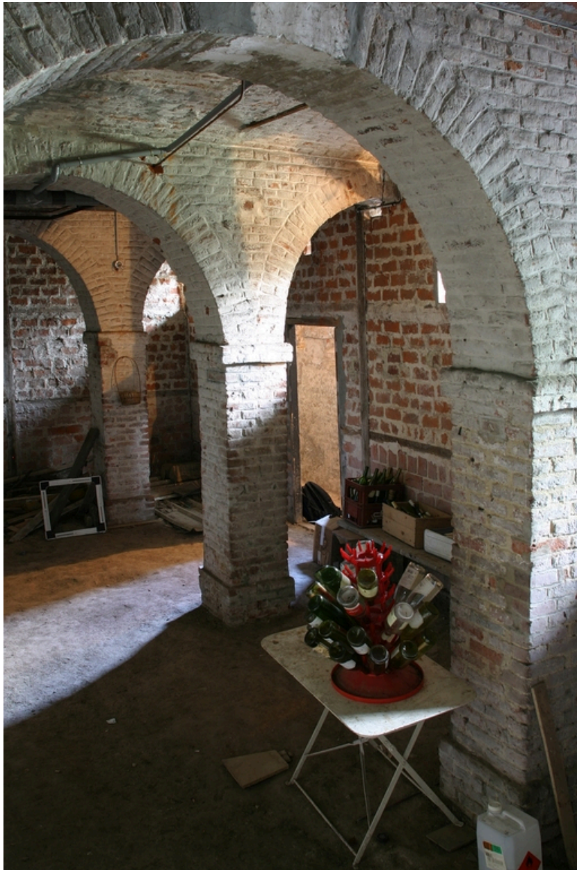
Vestiges du tissage, partie nord : sous-sol.
